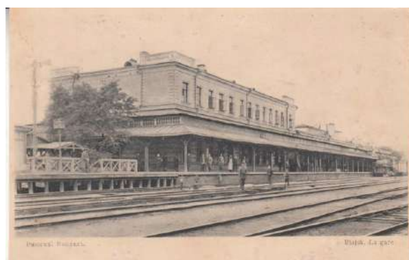
Станция Рязск, при которой находился госпиталь [7]
